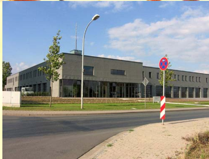
Bild 4 Gefahrenschutz Zentrum in der Kromsdorfer Straße 13
